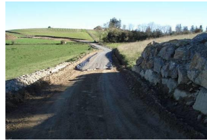
Illustration 24 : Mise en place du gravier
