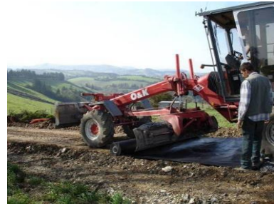
Illustration 23 : Pose du géotextile
